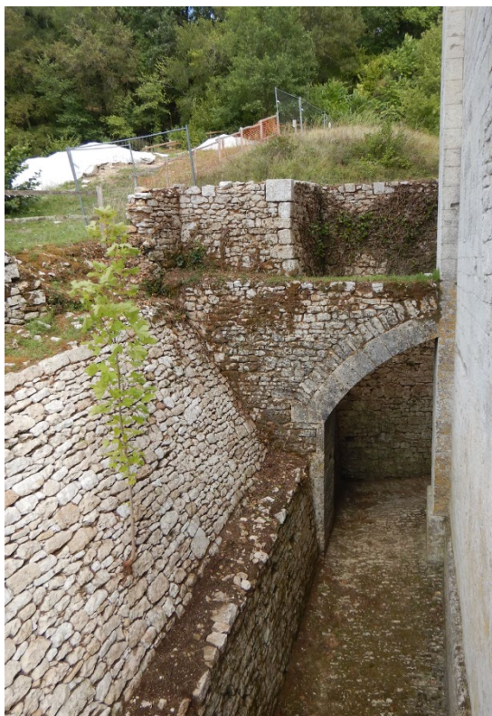
Vue du dégagement des murs du chemin de « l'abbé Carrier », au nord du transept nord de l'église abbatiale (cliché P.-M. Blanc).
